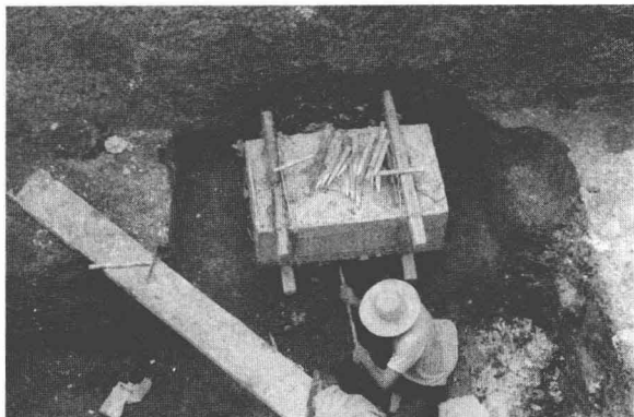
图10 用绳索或铁丝将各底板与木质框架绞紧
