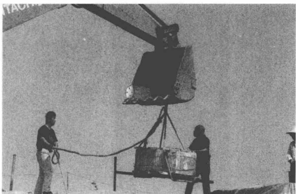
图12 用吊车起吊箱体 (2)
