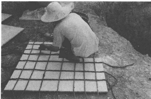
图5 套箱框上下底表面布井字形麻绳以加强套箱承载力
