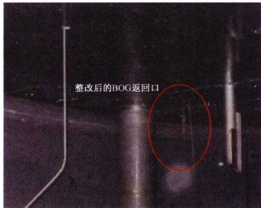
图 2-12 整改后的 BOG 返回口接管
