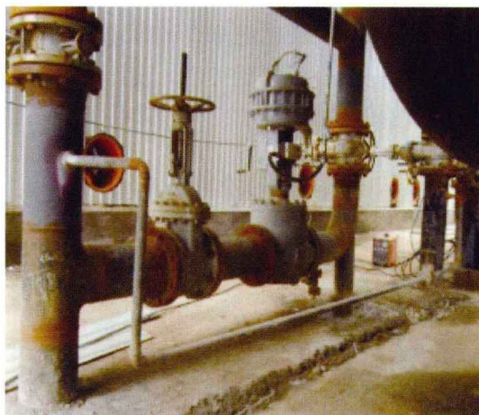
图 2-10 整改后的旁通管线
