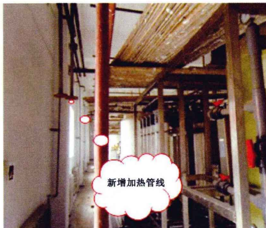
图 2-18 设计新增的加热管线
