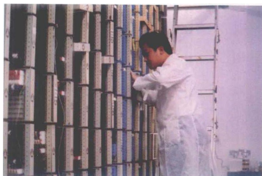
用户线跳线容量2.6万线的测量室。
