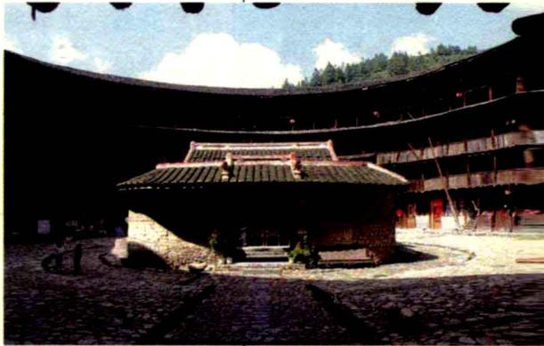
“裕昌楼”从外墙夯土建筑上看不出有何不同，其奇特之处，一进楼门即会见到三楼以上内圈回廊上的一些立柱东倾西倒，因此本地人称其为“七歪八斜楼”。“七歪八斜”的使然有个传说，开建时由资深的建筑师傅主持，建完了一、二层后，师傅另有任务，同时想考验徒弟的能耐，把续建的工程交给徒弟。徒弟续建外圈的生土围墙没有出现问题，内圈回廊上的立柱却成了东倾西倒的模样，但建成后检测认为不会影响使用质量。700年过去，土楼完好无损也证明了它的坚固。传说归传说，事情的缘由是否如此，近700年前的物事缺少文字实录，谁也说不清楚。但有一点可以认定，与土楼有很强防震功能的道理一样，回廊局部立柱的七歪八斜，由于圆楼外围的稳固，内部木质结构梁柱歪斜而彼此间的相互牵引扶持，其合力整体性没有受到破坏，最高的五层楼也不会倒塌，其中蕴涵着一定的科学道理。
