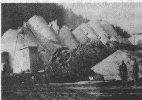
图 1-4 纽约某水泥仓库的地基破坏事故
