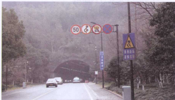
图 1-26 易发生危险路段
