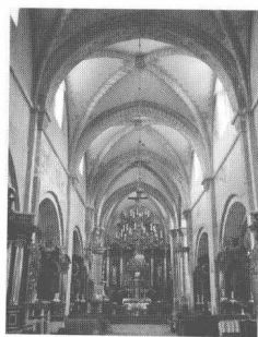
科泊石厘尼礞：西多会修道院，建于约公元1220年，室内：早期哥特式典型的肋拱结构。
