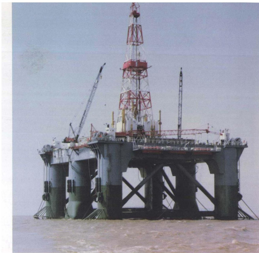
1979年，船舶检验局上海办事处执行建造检验与发证的我国第一座半潜式钻井平台“勘探三号”。
