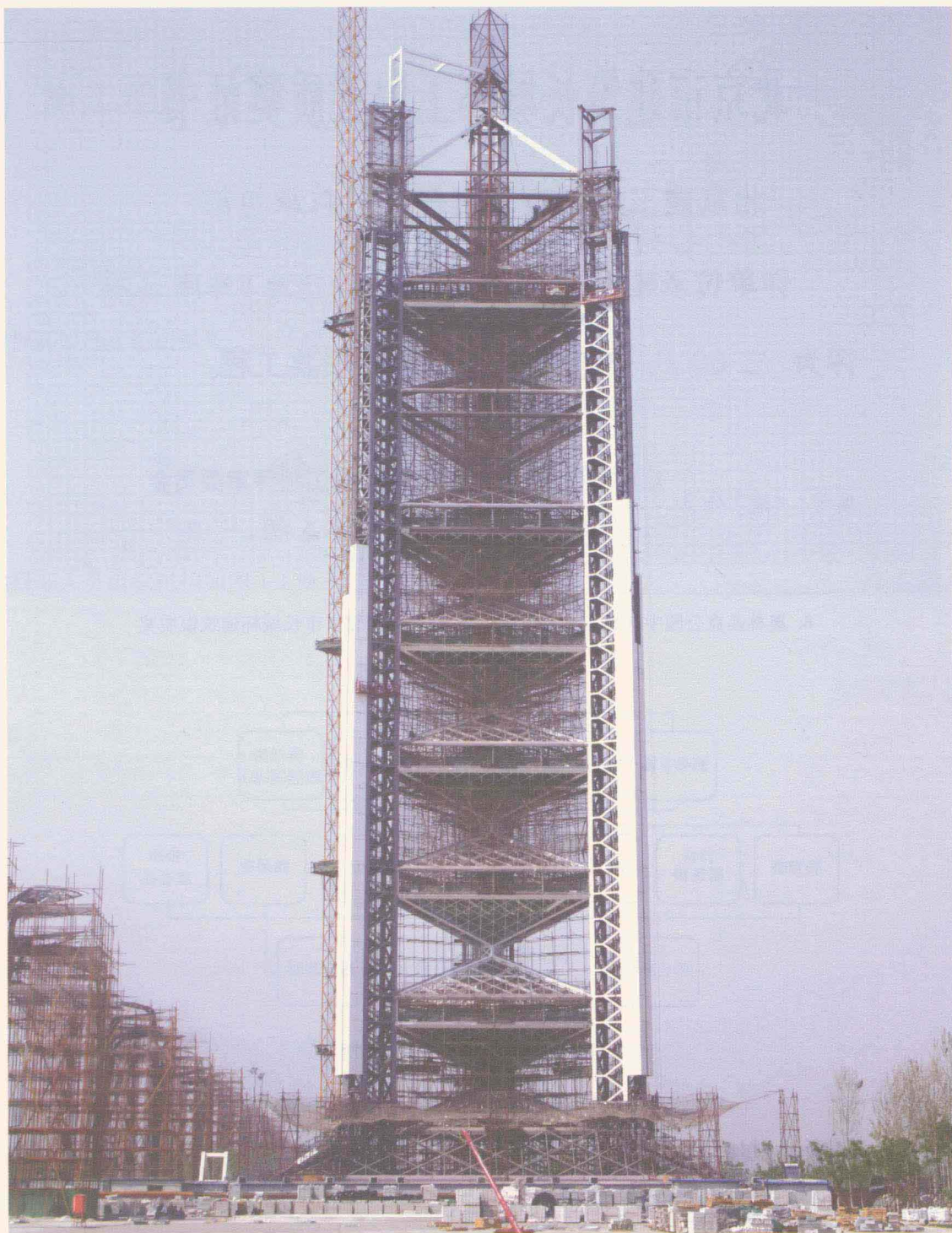
5. 多功能演播塔结构封顶
