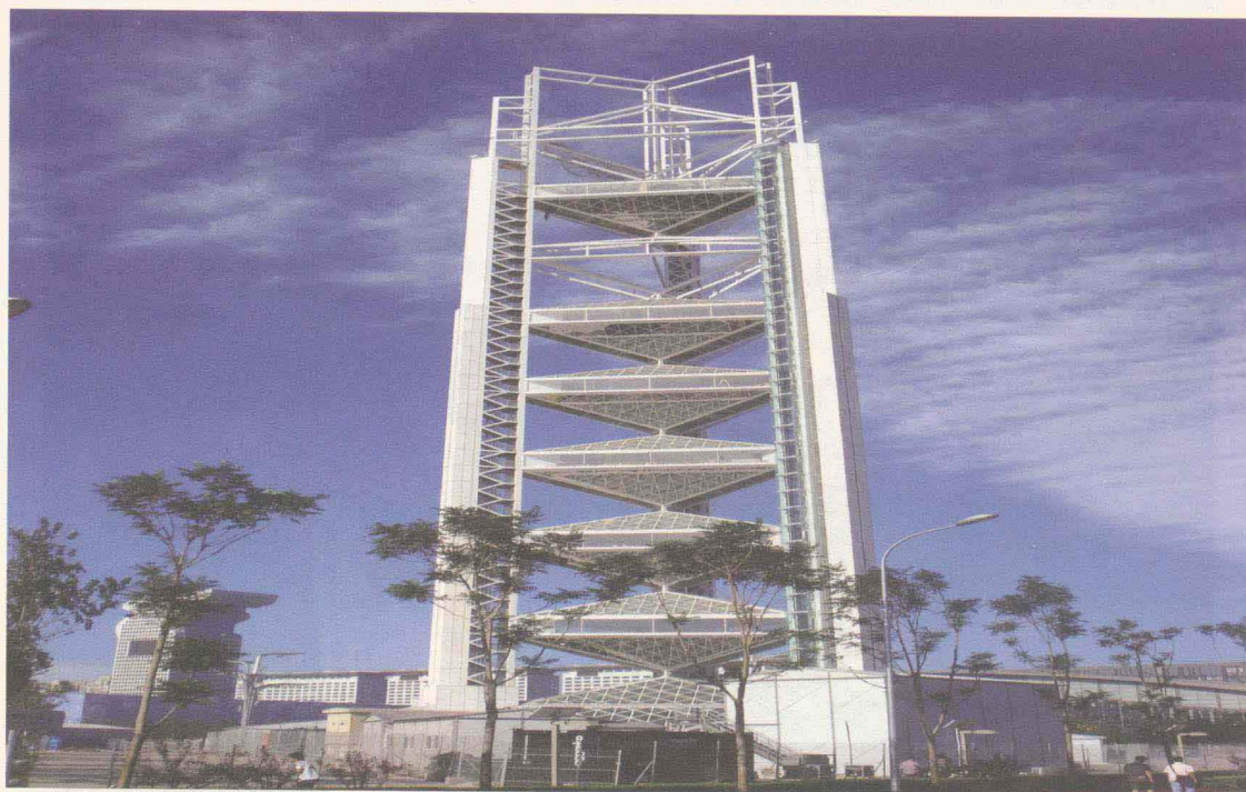
4. 多功能演播塔工程全景
