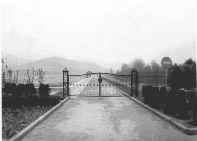
倪园水库大坝
