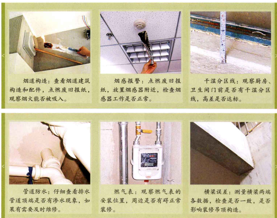
图1-15 厨房与卫生间构造验收（一）
