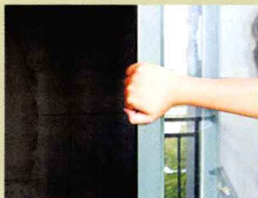
开启与关闭：多次开启、关闭门窗，感受阻力是否平顺。
