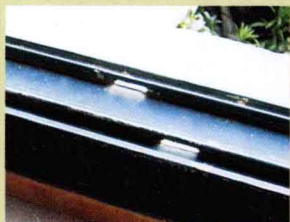
排水孔：观察门窗扇下部边缘是否有排水孔，排水孔是否在凹槽底部。
