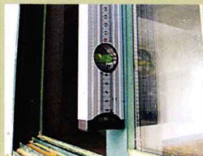
平直度：使用水平尺检查门窗框架是否垂直或水平。
