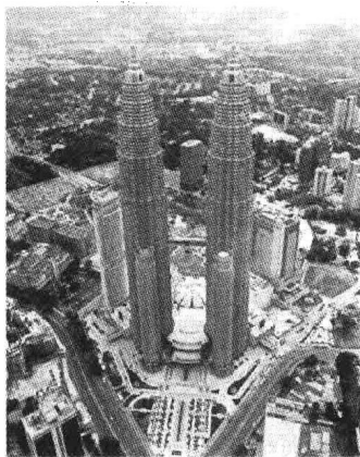
图 1-19 石油大厦双塔楼
