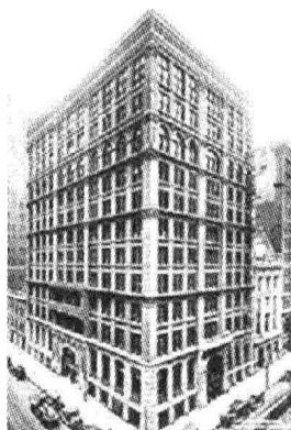
图 1-9 美国芝加哥的住宅保险大楼
