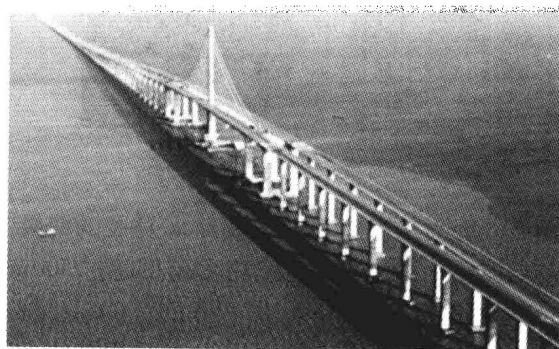
图 1-27 胶州湾跨海大桥
