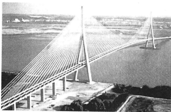
图 1-25 诺曼底斜拉桥
