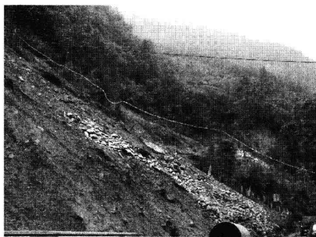
岷江上游一处修建电站破坏生态环境的情景
