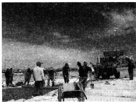
2006 年康定机场开工修建
