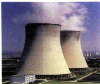
图 2-6 上海吴泾热电厂钢筋 混凝土双曲线冷却塔
