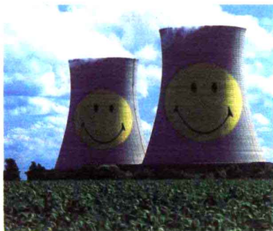
图 2-10 核能发电厂双曲线 冷却塔的艺术
