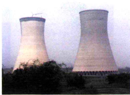
图 2-4 泸州电厂钢筋混凝土 双曲线冷却塔
