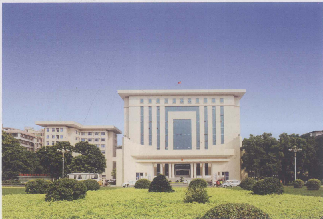
普宁市党政机关办公楼
