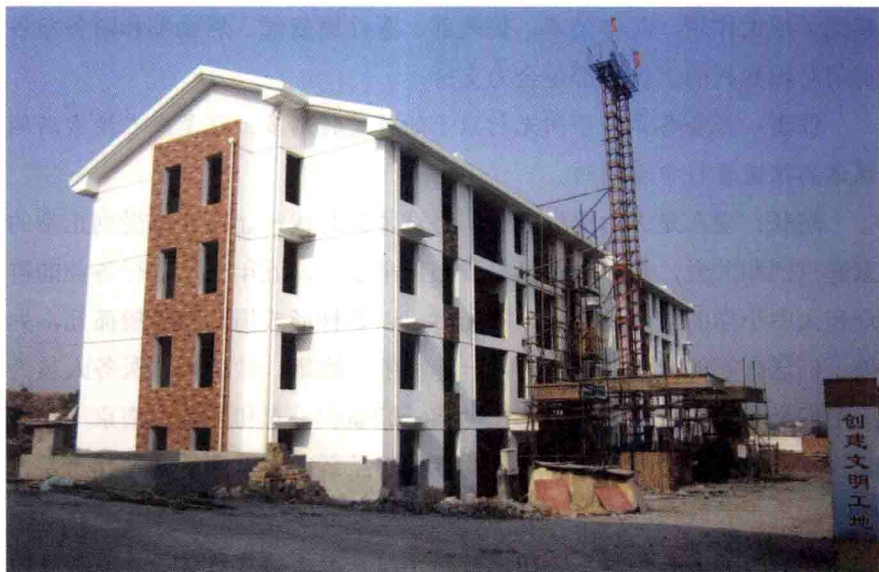
建设中的阳光村新公寓
