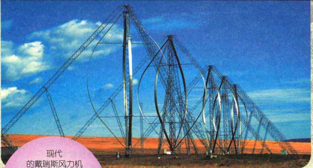
现代的戴瑞斯风力机（见下方题板）有4个弯曲的叶片围绕垂直轴旋转。它们不受风向的影响，并由钢缆固定，可以避免被大风损坏。
