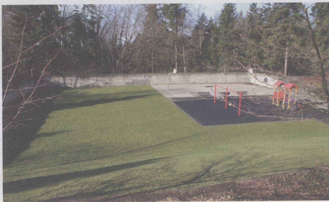
照片8.9 這是美國西雅圖附近的一個滯洪池，平時是一個公園及運動場地，特大暴雨時可發揮滯洪功能，減少下游洪災。
