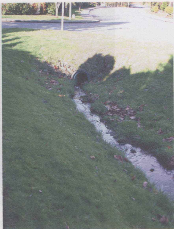
照片8.8 草溝可以排水，也可維護生態，並增加雨水入滲，是生態工法之一。
