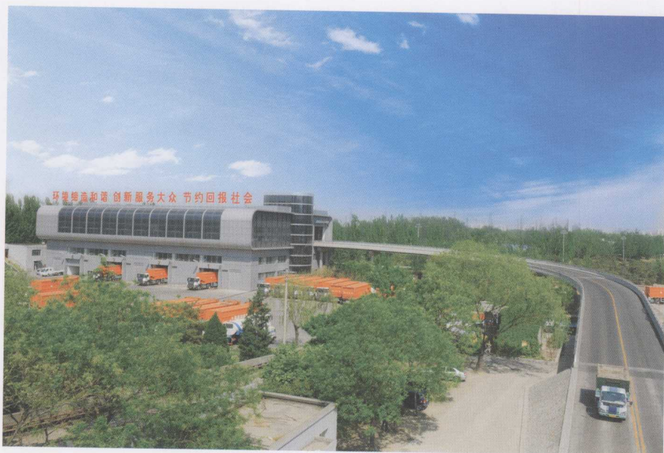
大屯垃圾压缩转运站
