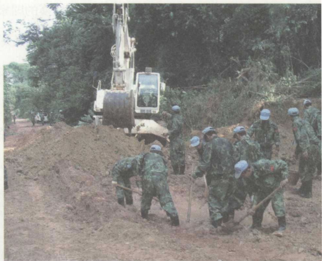
正在修复道路的中国维和工兵
