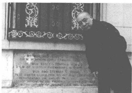
何新实勘上海北京西路共济会教堂 遗址石碑：共济会纪元5931年建立 （前4000年—1931年）
