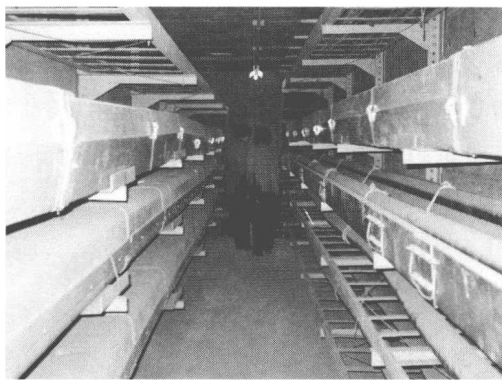
图 1-3 宝钢电力电缆隧道
