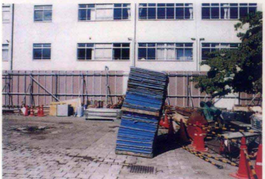
5 拆除建築物時做為隔音用的嵌板隨意堆置的情況。此種堆置法只要稍微有一點衝擊或震動就很容易產生倒塌。會產生這種情況主要是在堆置時沒有想到要將底部整平設置墊物才能使堆積物穩定。工地的安全管理人員應該要細心配合給予指導才對。
