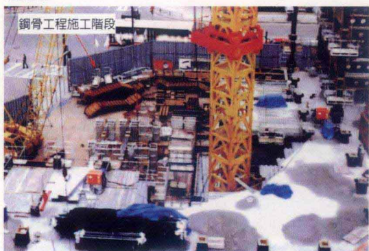
3 春季正刮強風之日，塔吊正進行鋼骨構件的吊裝工程。由於強風的關係使得前日下雨後留存於被吊上的鋼骨構件上的銹水被風刮下而淋到路過的行人身上。
