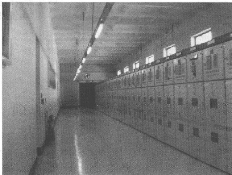
图 1-1 10kV 高压开关柜
