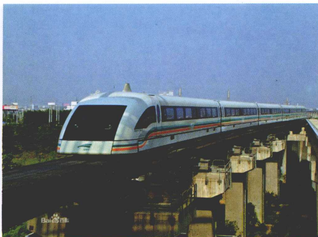
● 上海磁悬浮列车 专线西起上海轨道交通2号线的龙阳路站，东至上海浦东国际机场，专线全长29.8km。
