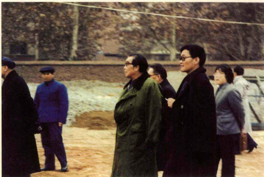
1985年12月中共河南省顾问委员会副主任韩劲草(左三)视察河南省图书馆新馆建设工地
