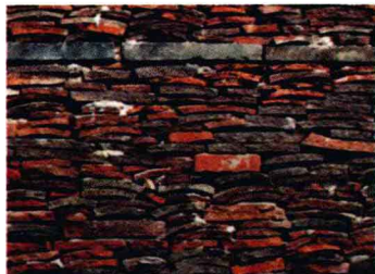
王澍,回收来的瓦片按照明代的建造方式进行铺砌,象山校区,杭州,2008年。
