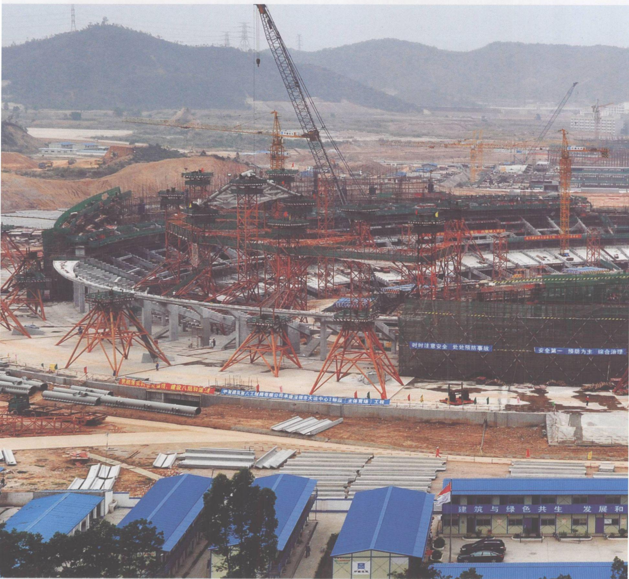
建设中的深圳大运中心体育场
