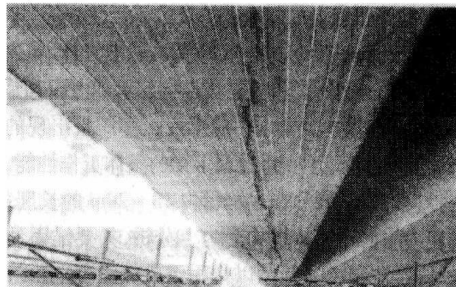
图 1-6 钢筋锈蚀裂缝
