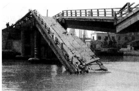
图 1-14 梁体塌落
