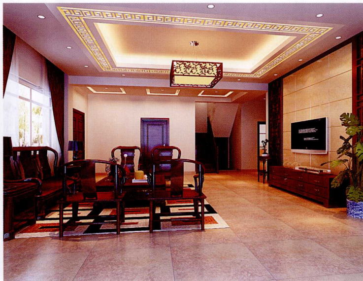
顶面 [ 石膏板造型 + 灯带 + 回纹线条雕刻刷白 ]
