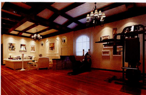
顶面 [ 杉木板装饰吊顶刷白 + 木装饰梁 ]
