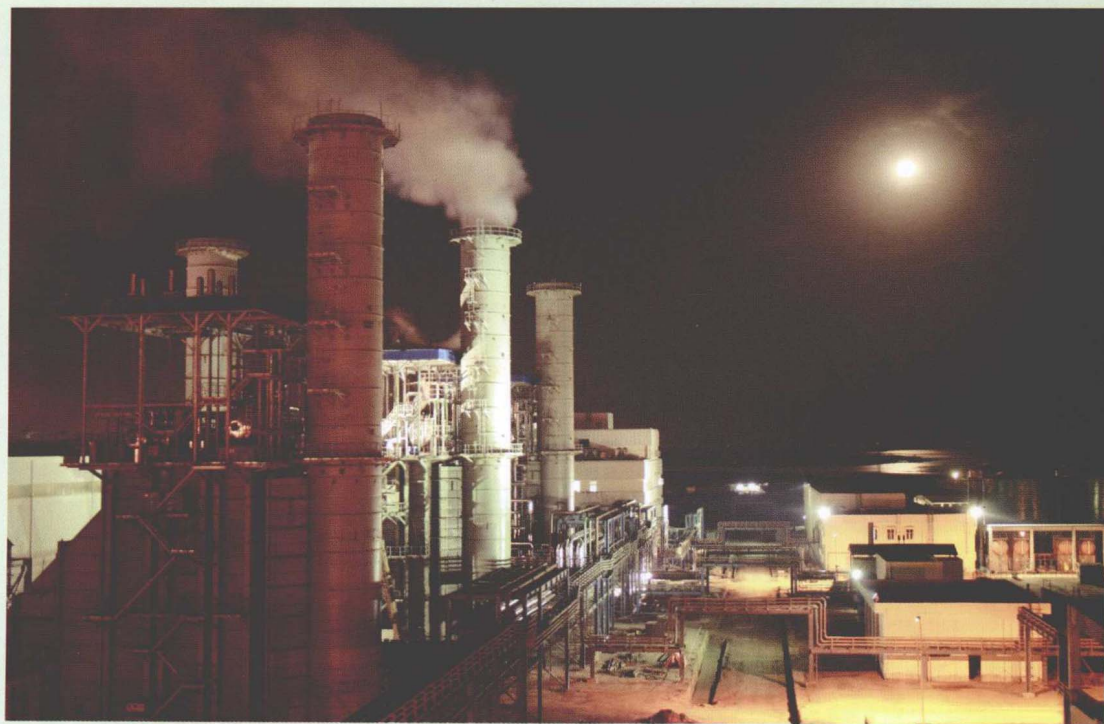
■ 余热锅炉煮炉
