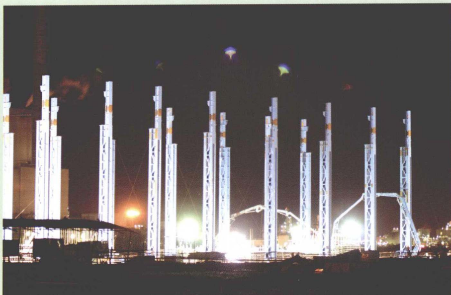
■ 燃机基础混凝土浇筑
