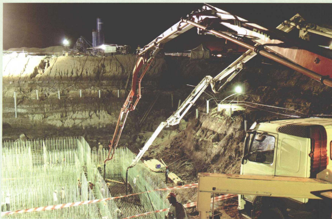
■ 循环水泵房基础浇混凝土
