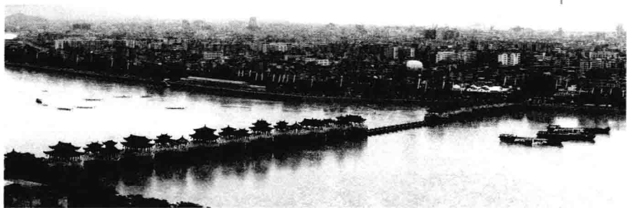
修复后的广济桥
