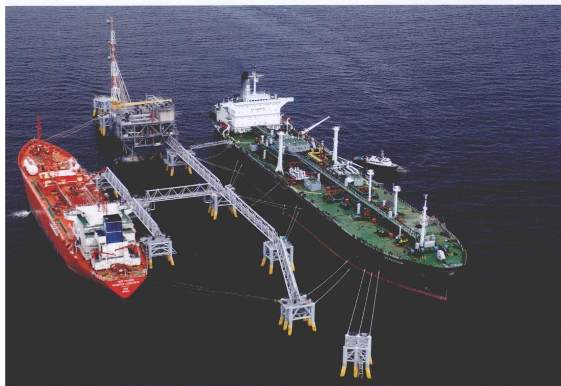
Jabung区块LPG处理厂海上设施
