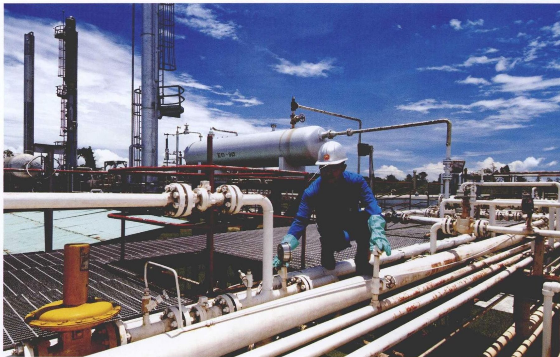
Basin区块作业现场
