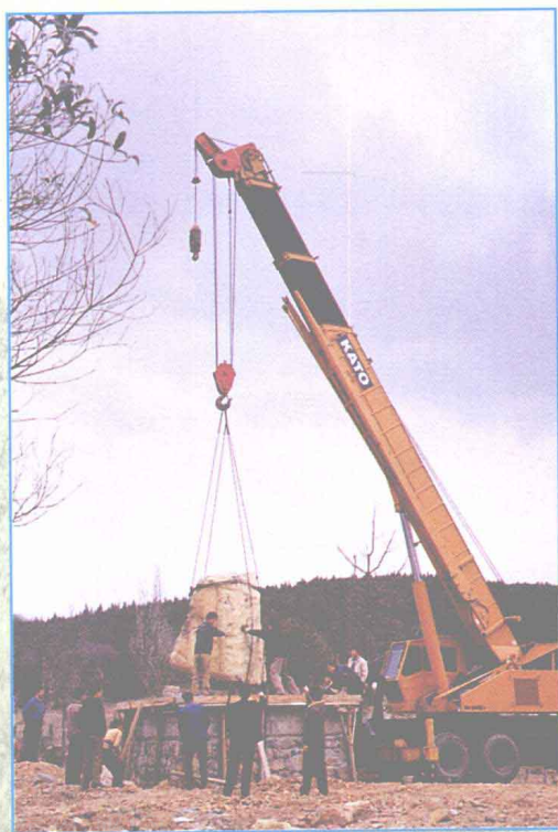
“新四军纪念林”施工现场
