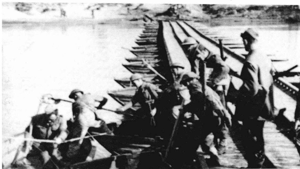
▼紧急架设浮桥的英军工程兵部队。
