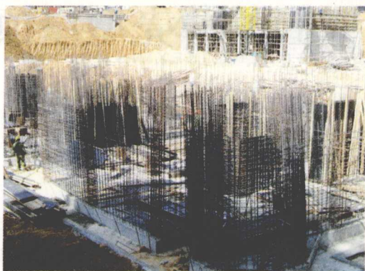
建筑工人正在为高楼打地基
