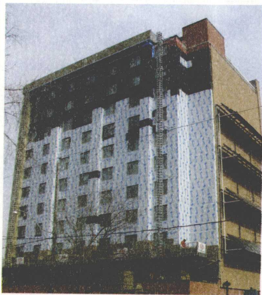
采用保温体系的建筑物
