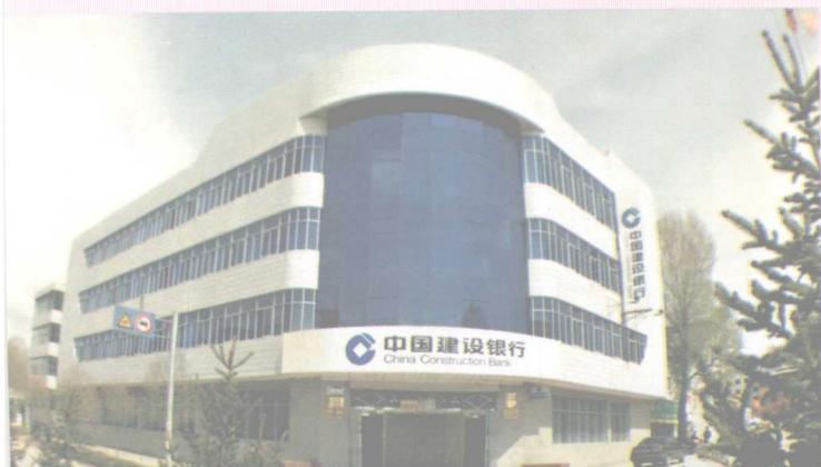
州建行办公大楼
