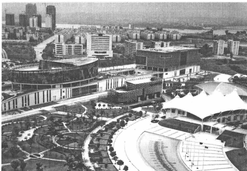
图 1-5 某 110kV 城市室内变电站鸟瞰
