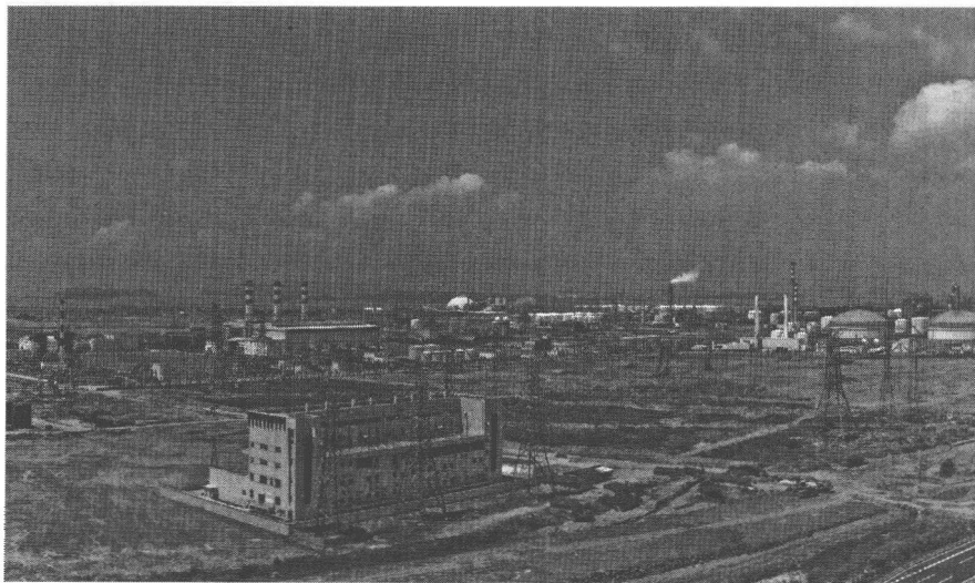
图 1-4 某 220kV 室内变电站鸟瞰
