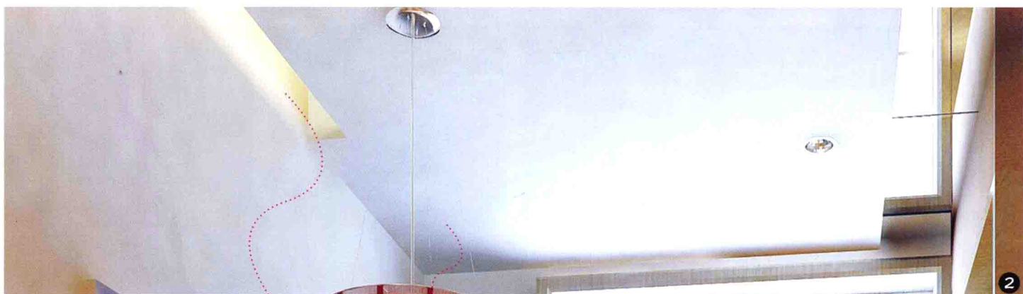
黄色暗藏灯槽 石膏板造型
