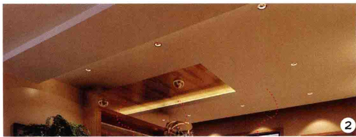
木制造型 黄色暗藏灯槽 石膏板造型
