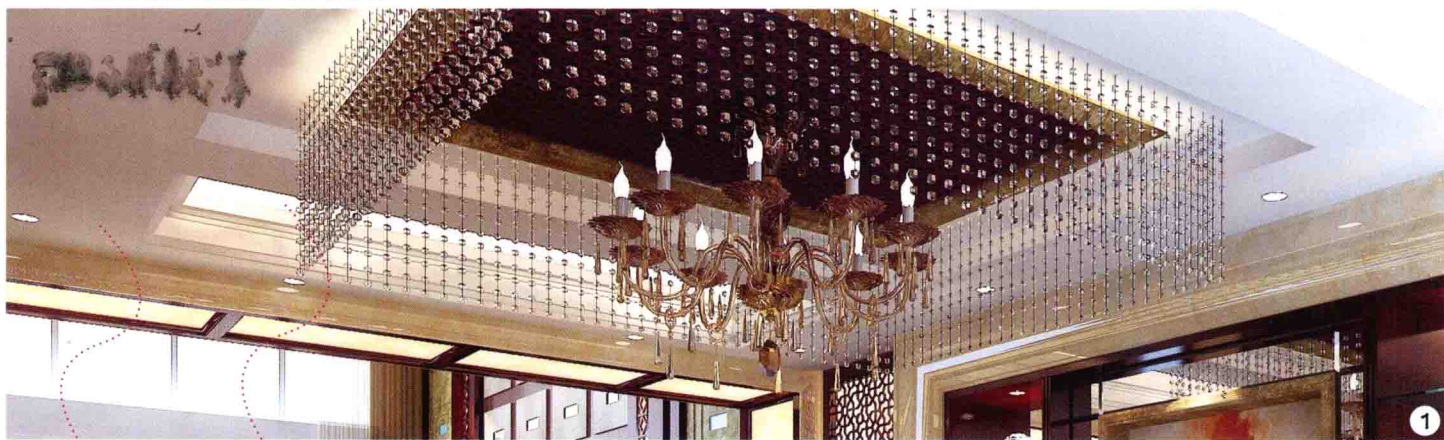
石膏板造型 白色暗藏灯槽
