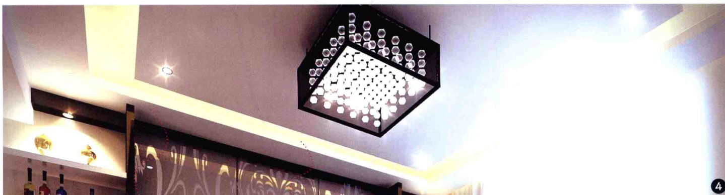
石膏板造型 黄色暗藏灯槽
