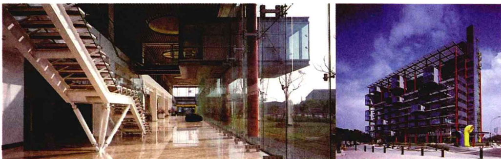
图1-4 ChingFu集团总部大楼
