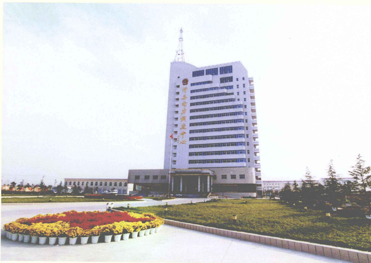
滑县电力调度中心
