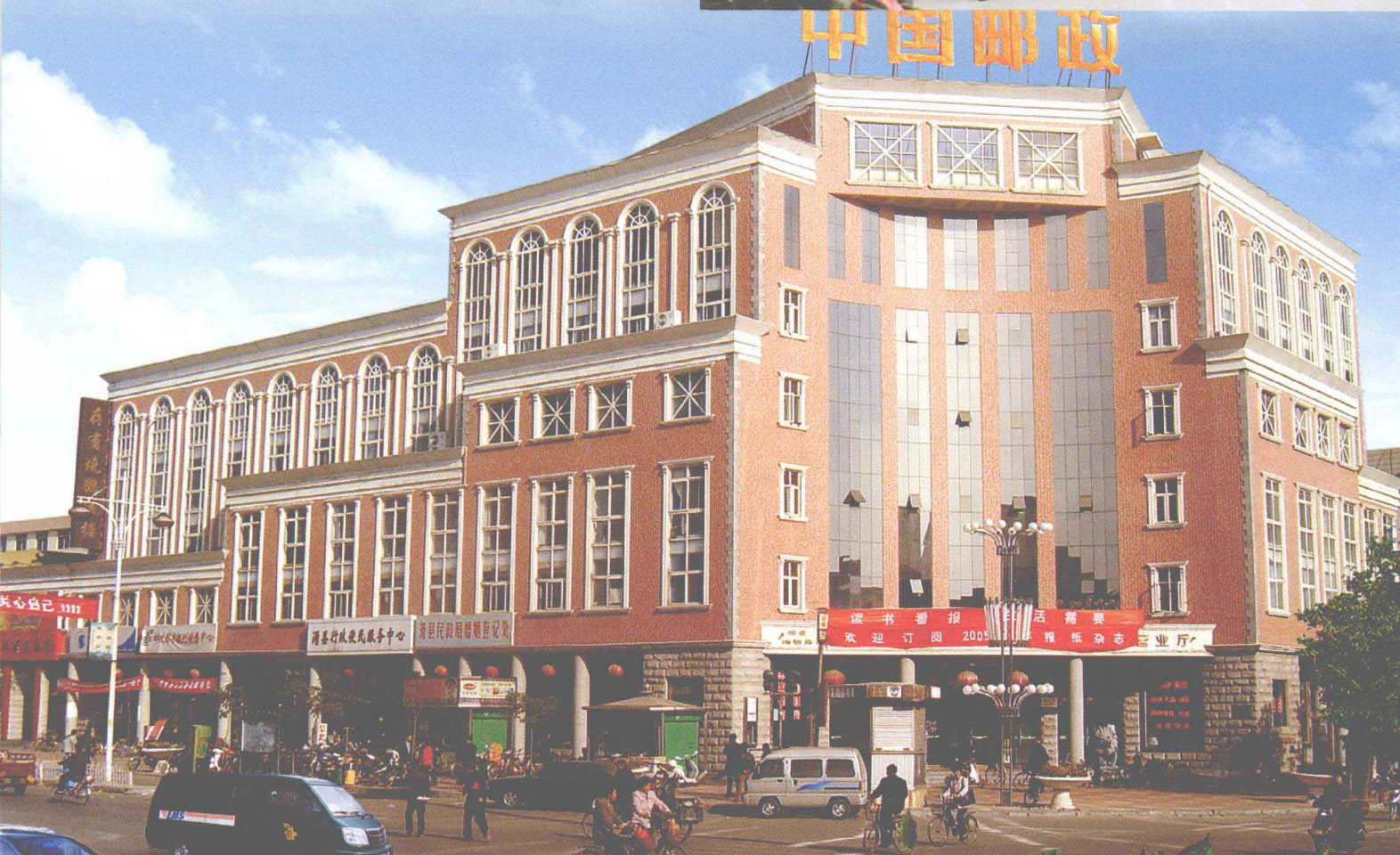
滑县邮政局综合办公楼
