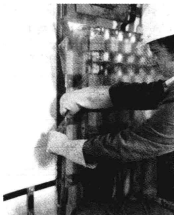
图 1-12 遮盖带电部分
