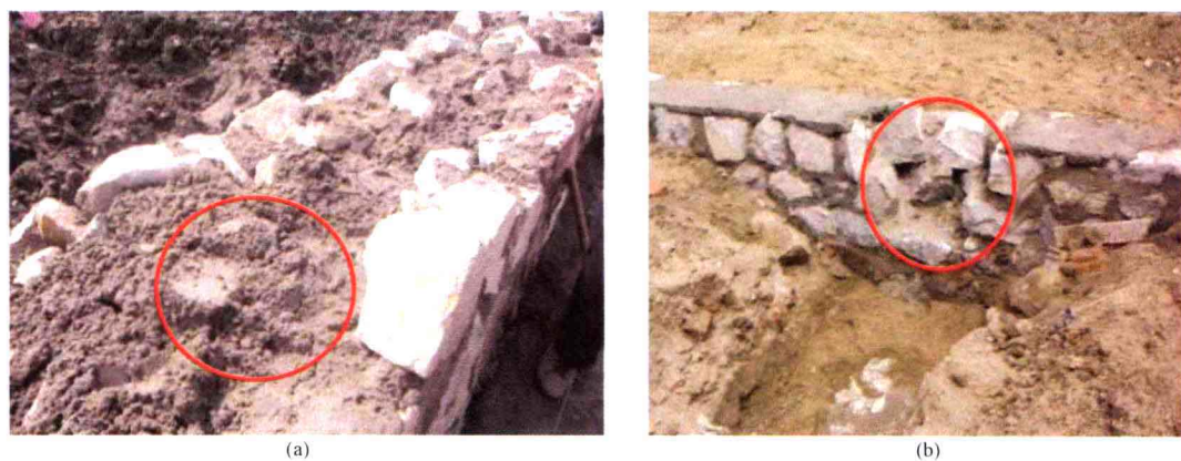
图 1-2-2 毛石砌筑无拉结石
