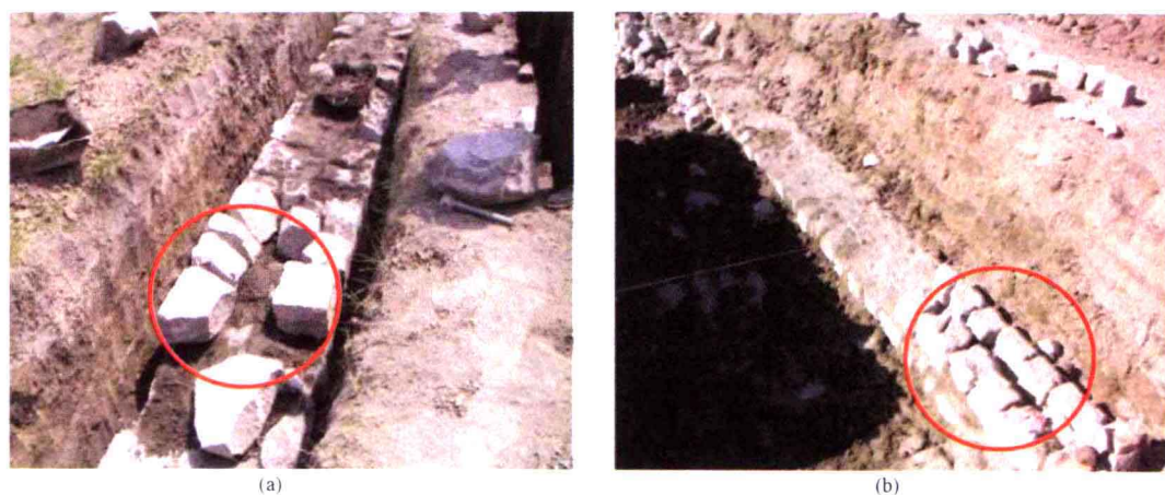
图 1-2-3 毛石基础“牛槽砌筑”
