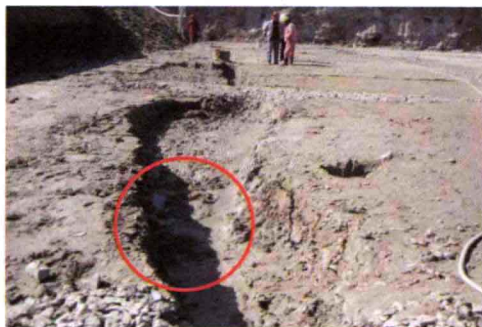
图 1-1-4 基坑排水不畅,基土扰动
