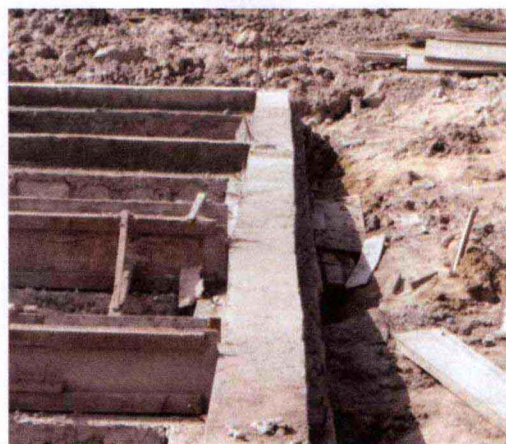
图 1-2-7 混凝土外形尺寸偏差超标
