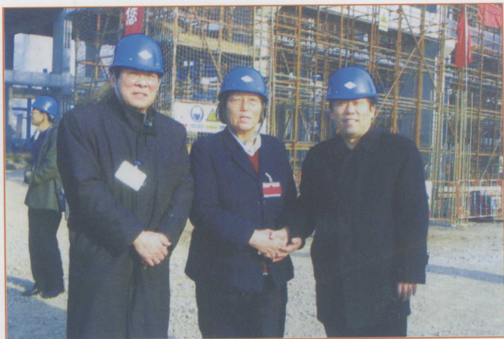
2003年12月3日，全国人大代表申纪兰在古交发电厂施工现场视察。
