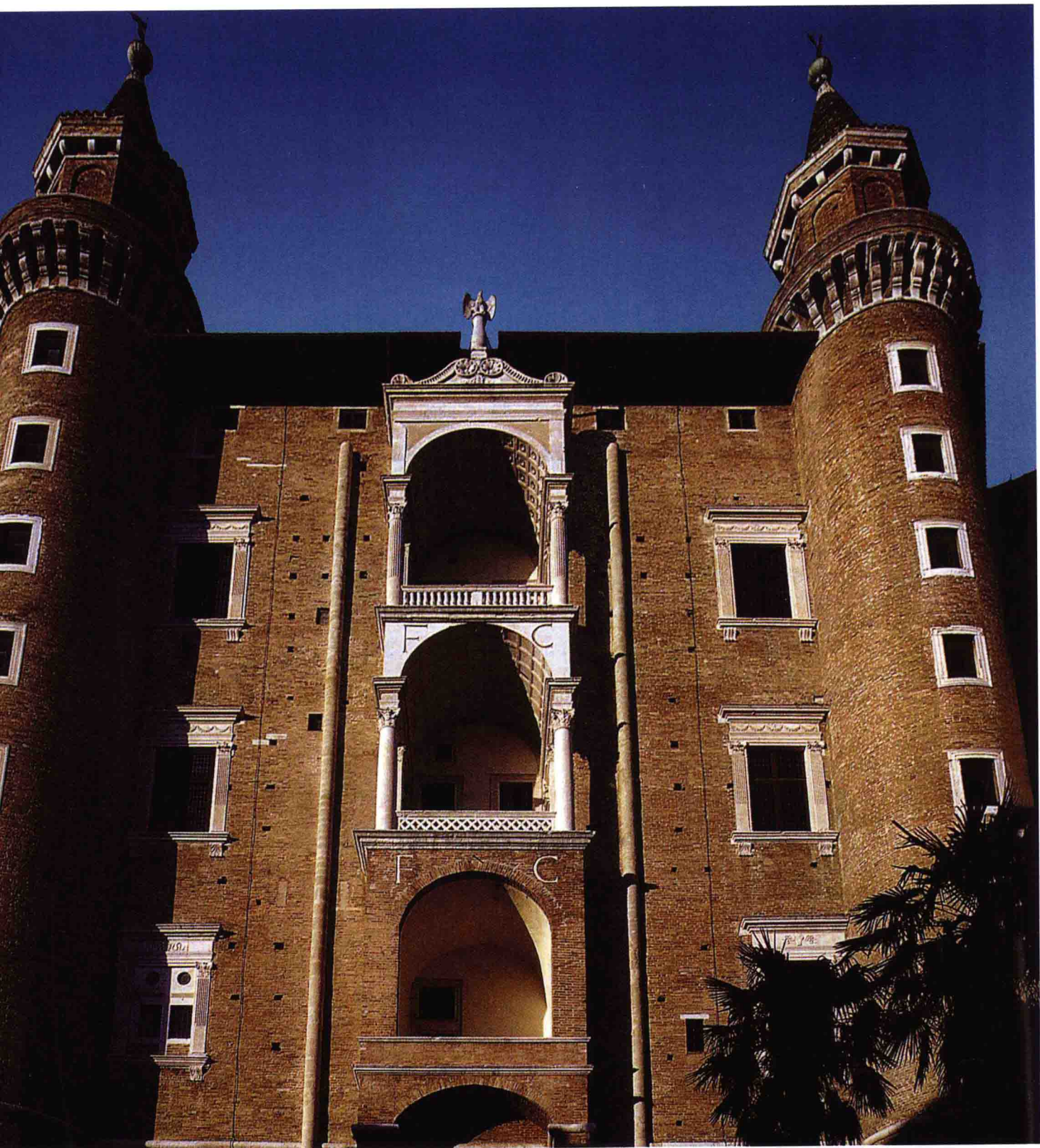
图 5-17 乌尔比诺 公爵府。西面敞廊及塔楼近景
