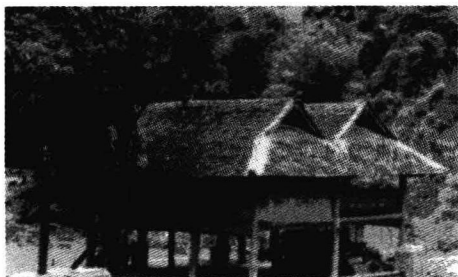
图 0-1 传统的吊脚楼
