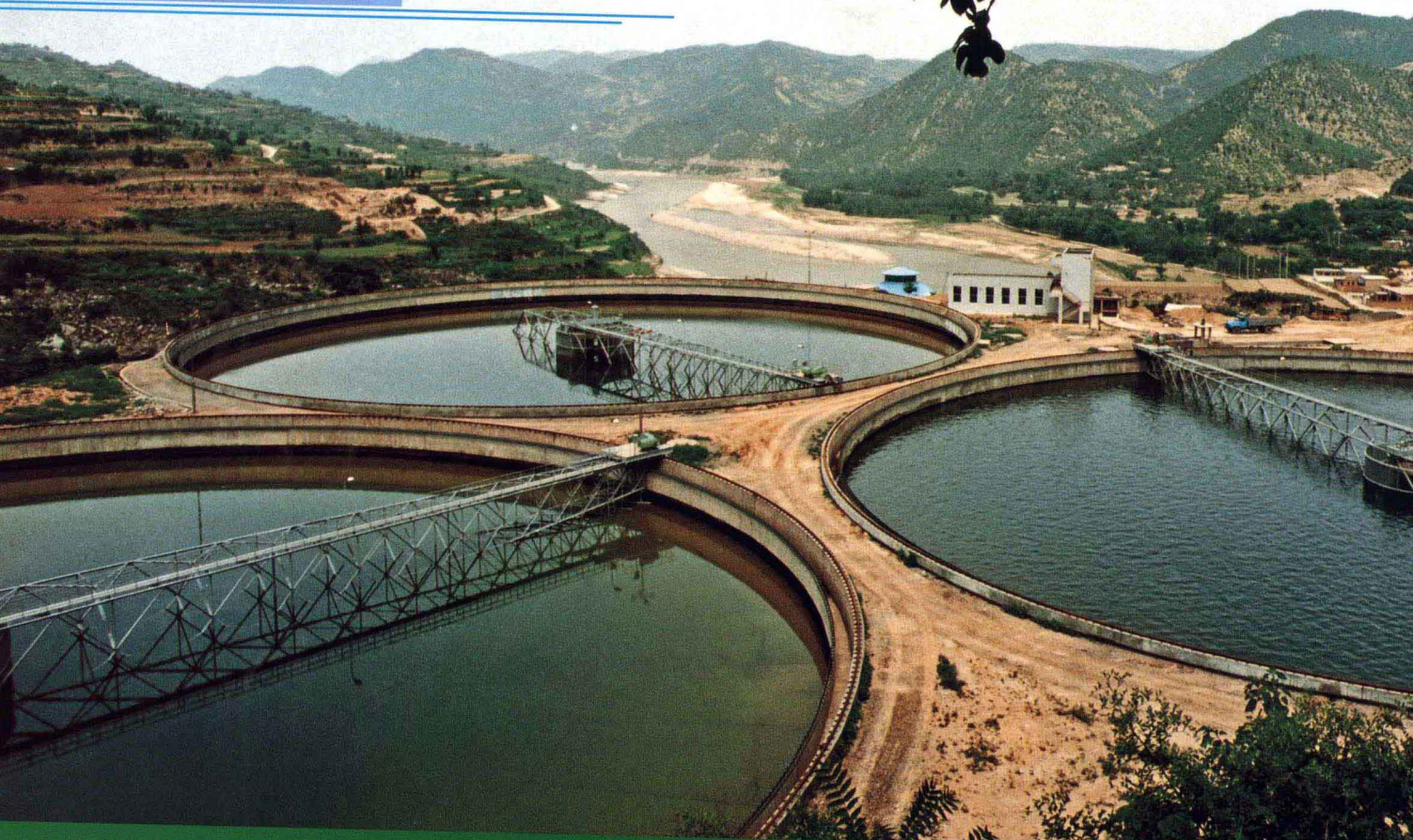
澠池槐機提水工程——渠首
