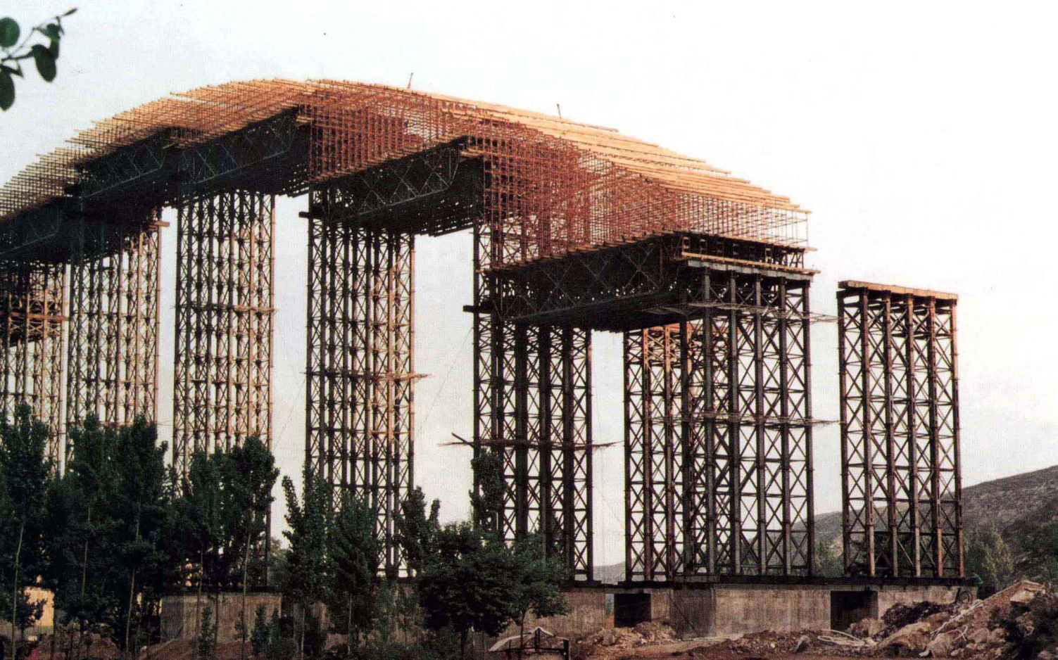
建设中的洛三高速公路许沟特大桥
