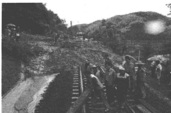
图 2.1 鹰厦、横南铁路边坡塌方
