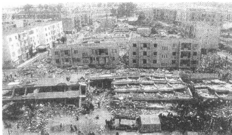
图 1-10 建筑物的倒塌破坏
