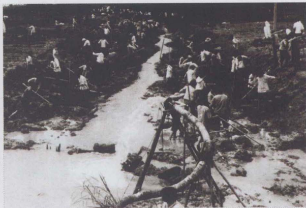
1970年,海宁县袁花公社社员开挖河道
