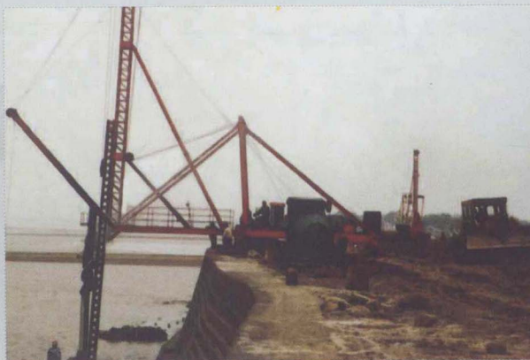
2001年,钱塘江北岸标准海塘机械施工
