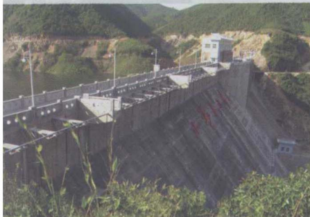
临安水涛庄水库
