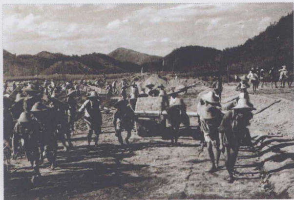
1958年,对河口水库大坝施工
