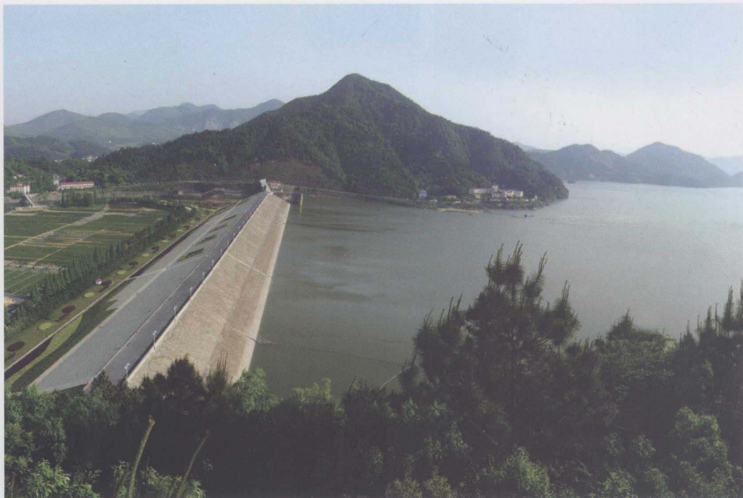
临安青山水库
